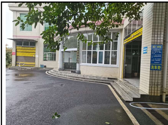
现有工程化验室
