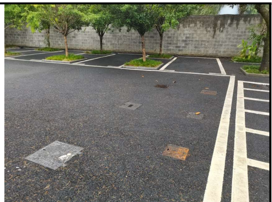
现有工程化粪池
