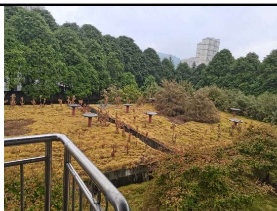
现有工程清水池（表面植被覆盖）
